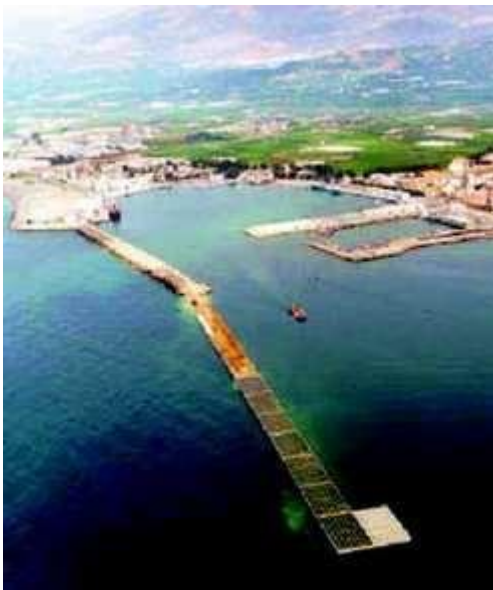
Dique vertical con cajones flotantes
